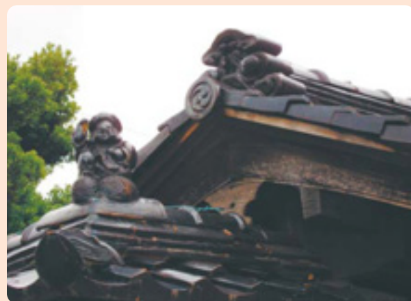
吉作の東京町と呼ばれた街道筋 旧商家の屋根に祀られた大黒様の飾り瓦。
