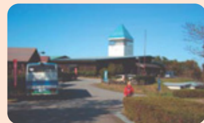
古洞の湯(古洞の森管理棟)
